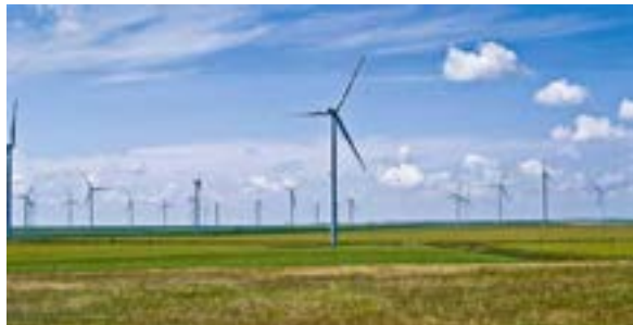
Сурет 2 – Жел электр станциясы
